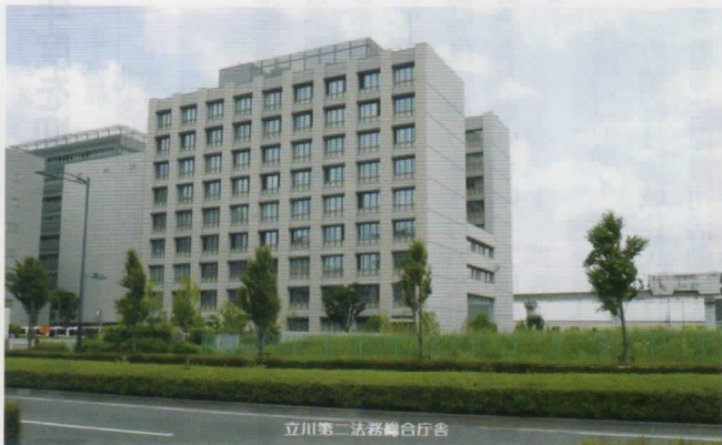
立川第二法務総合庁舎
