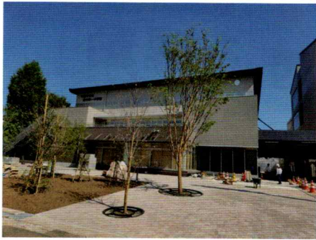
府中市立府中第一中学校建物外観
